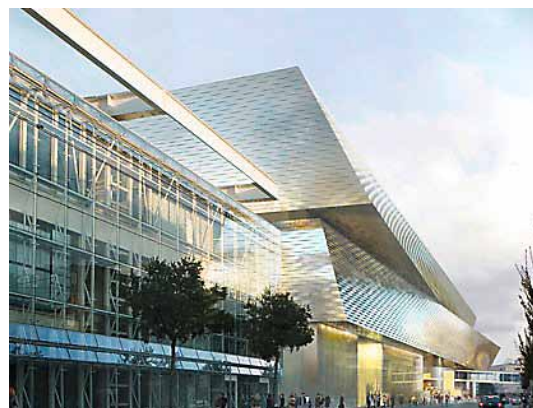
Die neue Halle für die Baselworld ist termingerecht fertig geworden. Bild: zVg
